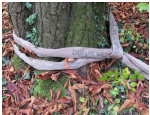
3.4. ábra: A fákat hevederek alkalmazásával védjük.
